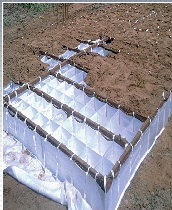
■ В конструкции тканых геоболочек
