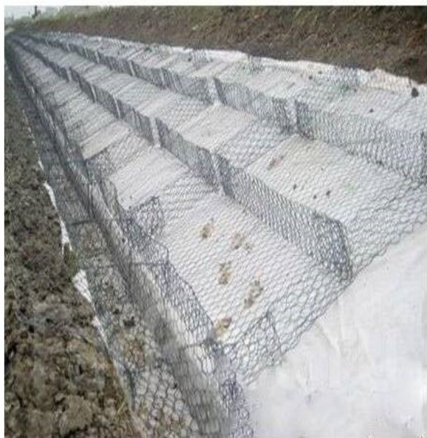
▪ Геотекстиль с габионными конструкциями
